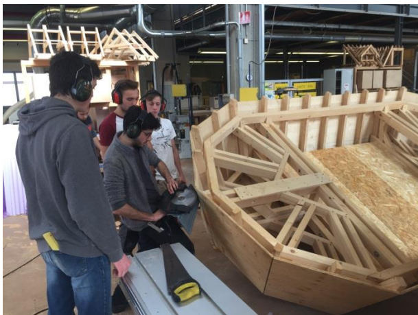
Chantier-école au Lycée des métiers du BTP de Cernay © Jan Kopp
